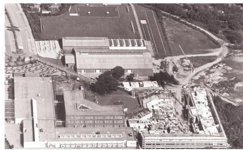
Baustelle Berufsschulzentrum: Links der erste Teil der Gewerblichen Beruflichen Schulen (GBS), rechts die in Bau befindliche Hannah-Arendt-Schule, mittig die Fördehalle. Es fehlt der zweite Teil der GBS zwischen Teil 1 und Fördehalle.
