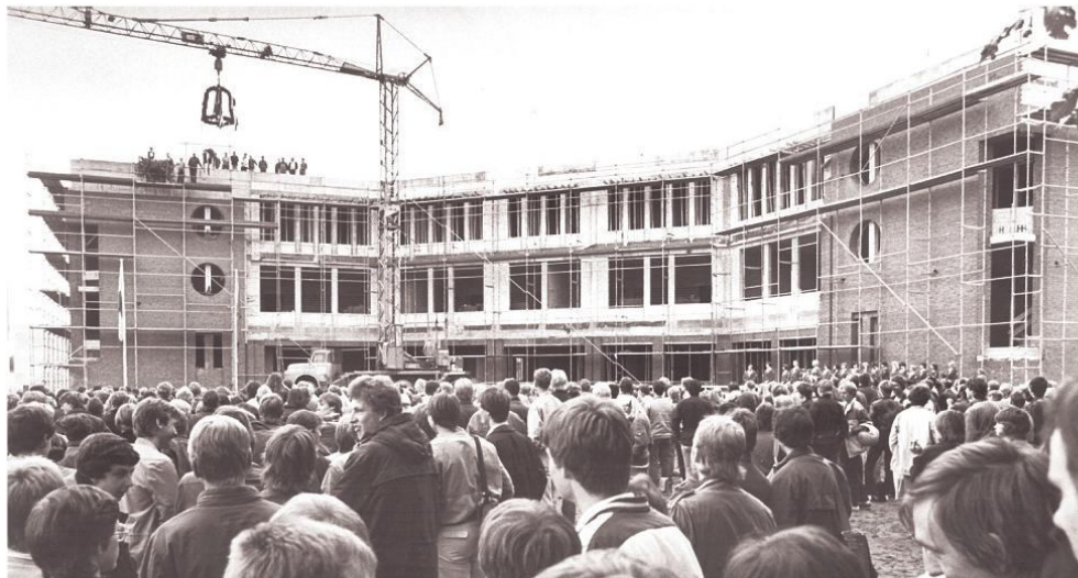
Ein Anfang ist gemacht: Richtfest für den ersten Bauabschnitt im September 1984.
